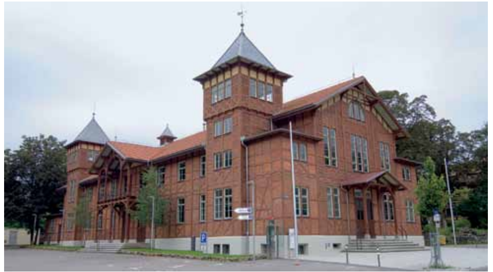
Der historische Fachwerkbau der 170 Jahre alten Gigelberghalle in Biberach litt unter einem unbehaglichen Raumklima.
